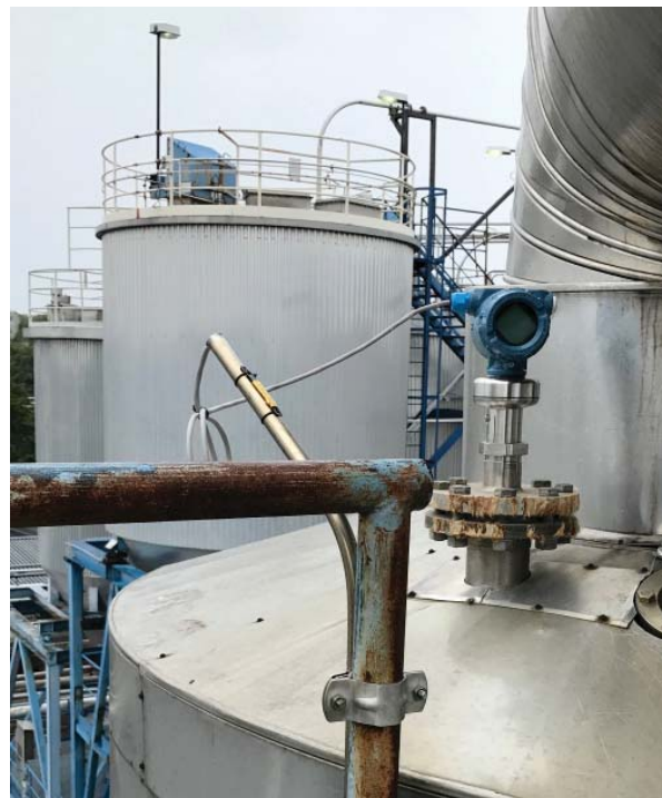
На рисунке показан Уровнемер 5408, установленный на циклонном реакторе
